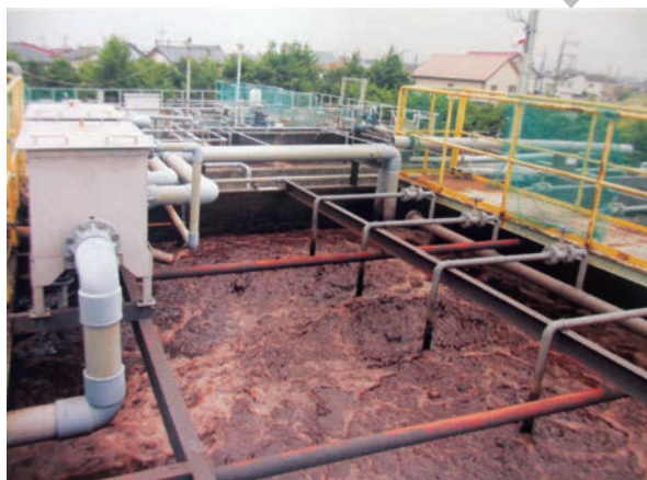
排水は浄化してから川に戻す。
